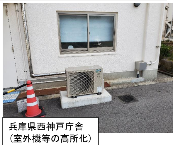
図 6.6.1 重要施設の耐水化事例イメージ
