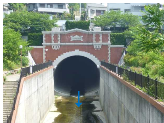
図 2.4.10 湊川隧道（新湊川） 【吐口側】
