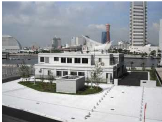
図 2.4.18 京橋ポンプ場
