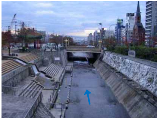
図 2.4.6 生田川上流部
