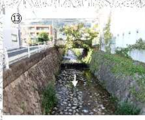
岡本橋より上流を望む
