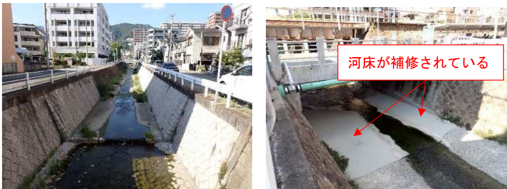
図 2-12 コンクリート三面張りの様子
