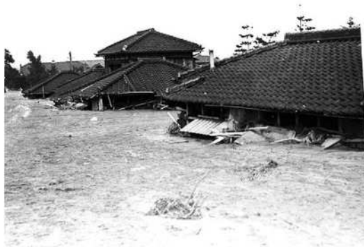
図 1-2 阪神大水害時の東灘区本山の様子
