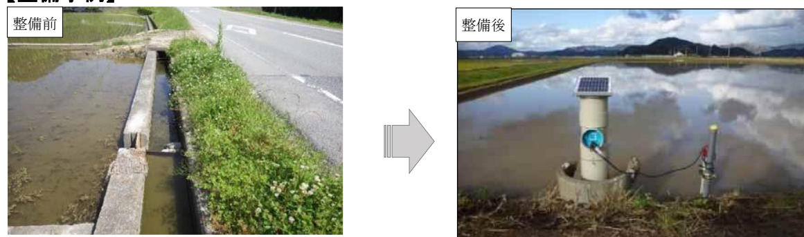
管路化（パイプライン化）
