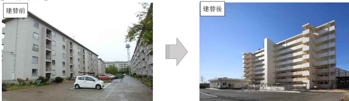
県営住宅の建替
