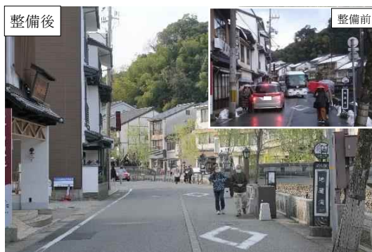
無電柱化対策
