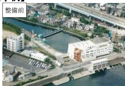
排水機場（更新）
