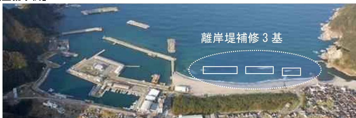
漁港海岸離岸堤補修
