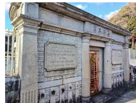
【立ヶ畑堰堤取水塔】
