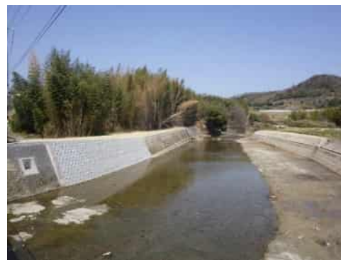
(一) 加古川水系淡河川（北区） 河川改修状況
