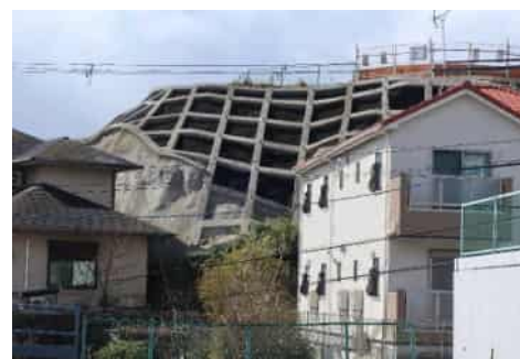
(急) 鈴蘭台北町(3)地区 (北区) 法枠工完成
