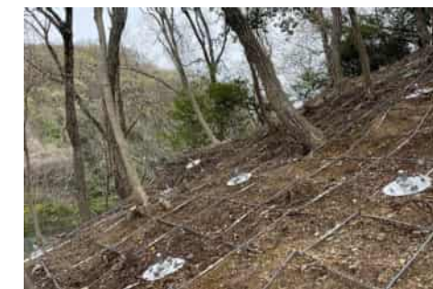
【地山補強土工 外大裏】
