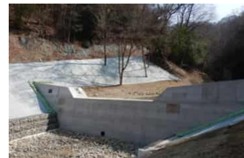
【治山ダム(施工中) 水無山】
