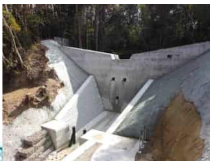
(砂) 八多川 (北区) 堰堤工完成
