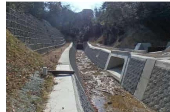
(砂) 蛇谷川（北区） 溪流保全工完成
