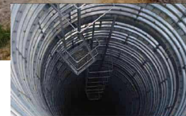
【地すべり対策事業 神戸地区 （北区淡河町北畑 集水井）】
