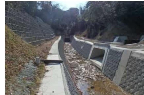
(砂) 蛇谷川（北区） 溪流保全工完成
