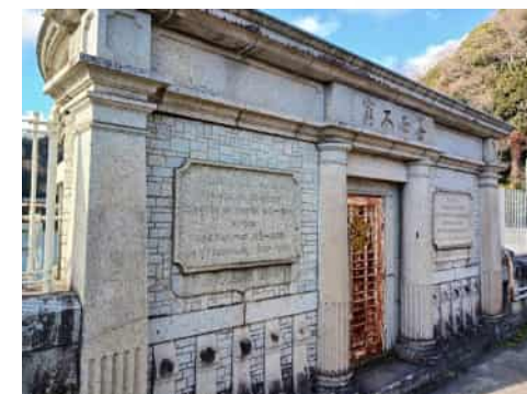
【立ヶ畑堰堤取水塔】
