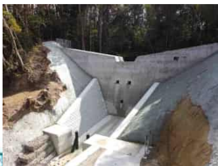
(砂) 八多川 (北区) 堰堤工完成
