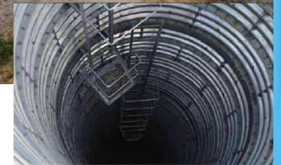
【地すべり対策事業 神戸地区 （北区淡河町北畑 集水井）】
