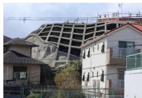
(急) 鈴蘭台北町(3)地区 (垂水区) 法枠工完成
