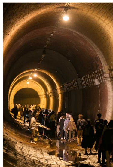
湊川隧道通り抜けの様子
