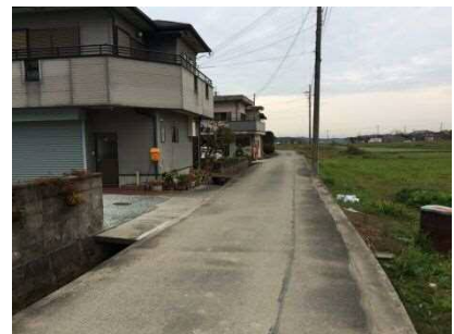
④保全対象人家
