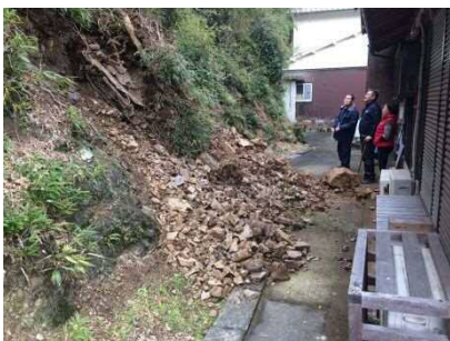
②斜面状況(人家裏)
