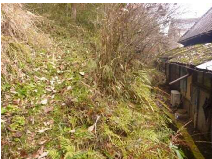
②斜面状況(人家裏)
