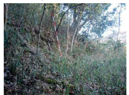
⑤斜面状況
