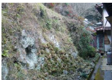
③保全対象とがけの状況
