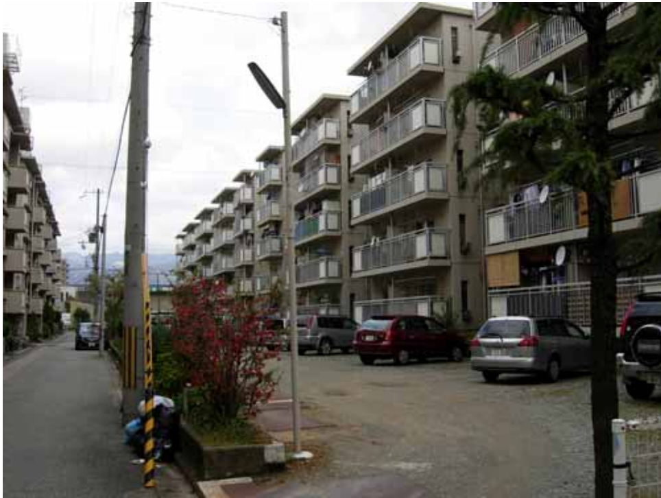
西宮浜松原鉄筋団地現状写真 外観：住棟南面を望む
