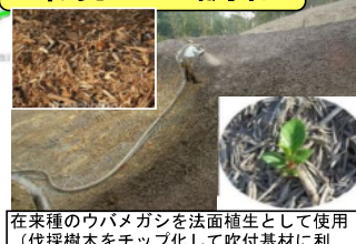
在来種のウバメガシを法面植生として使用 (伐採樹木をチップ化して吹付基材に利)
