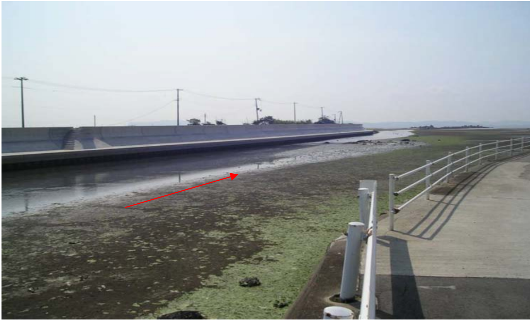
富島川河口部(築堤護岸整備済)
