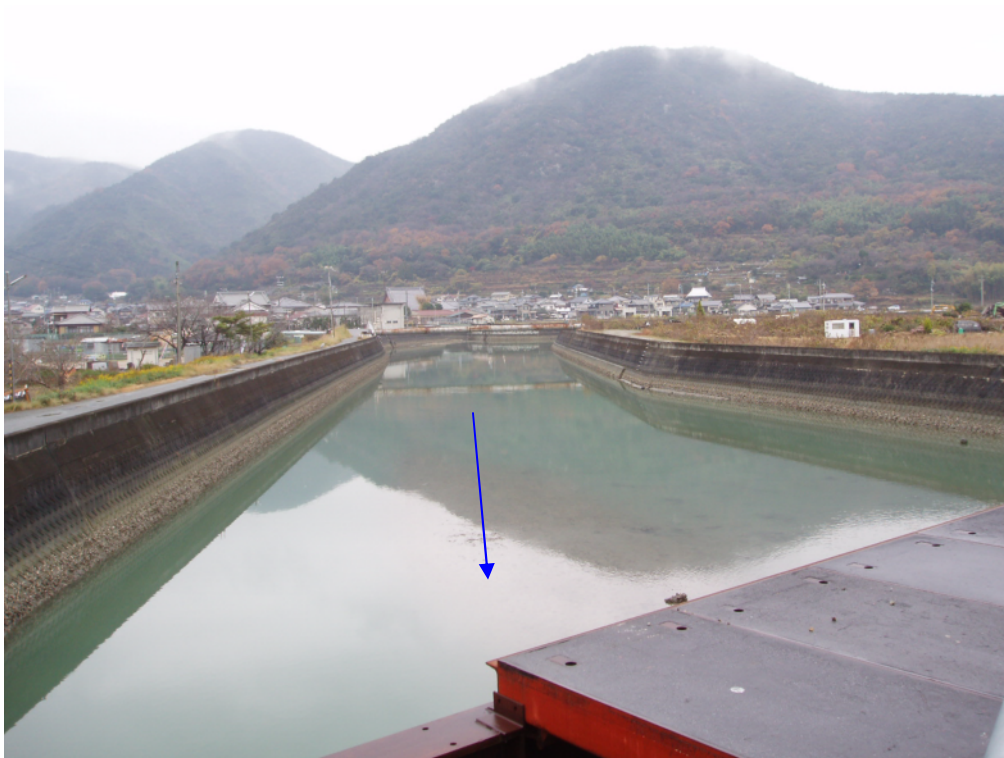
石ヶ崎橋～折方川合流点(整備済区間)
