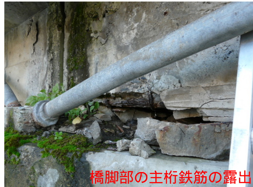
床版地覆部の鉄筋の露出
