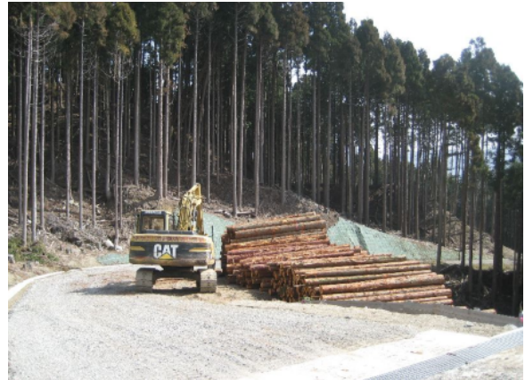
高性能林業機械による木材搬出状況
