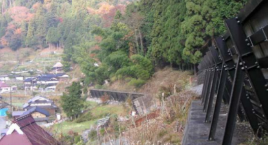
【落石の直接抑止】 落石防止柵（イメージ）
