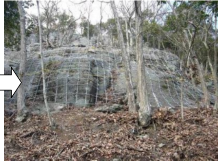
【落石発生の防止 固定工（イメージ）】
