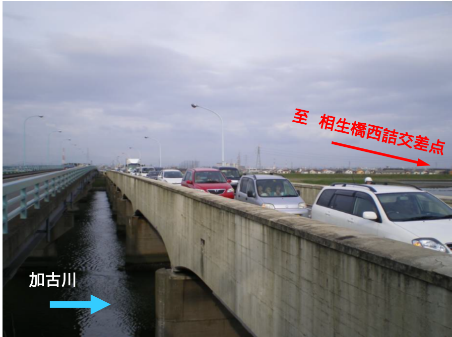
相生橋(旧橋) 西行き
