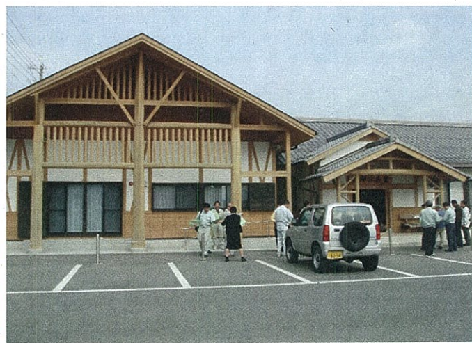
⑨NPO法人サウンドウッズのコーディネートによる加美区豊部交流センターの建築(平成14年度整備)
