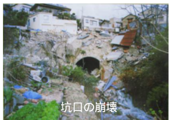
図3 改修前後の状況(トンネル吐口付近)
