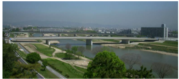
山手大橋工区(事業主体:西宮市、尼崎市)
