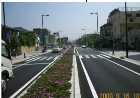
無電柱化を推進(西宮市寿工区)
