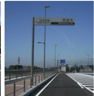
市境に設置したゲートサイン(山手大橋 西宮・尼崎市境)
