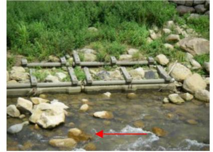
水面上に露出した木工沈床工
