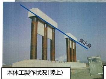
港内の水質悪化及び、魚等の生態活動に配慮した海水交換機能を有する構造
