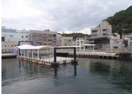
家島港旅客船ターミナル（平成24年11月完成）
