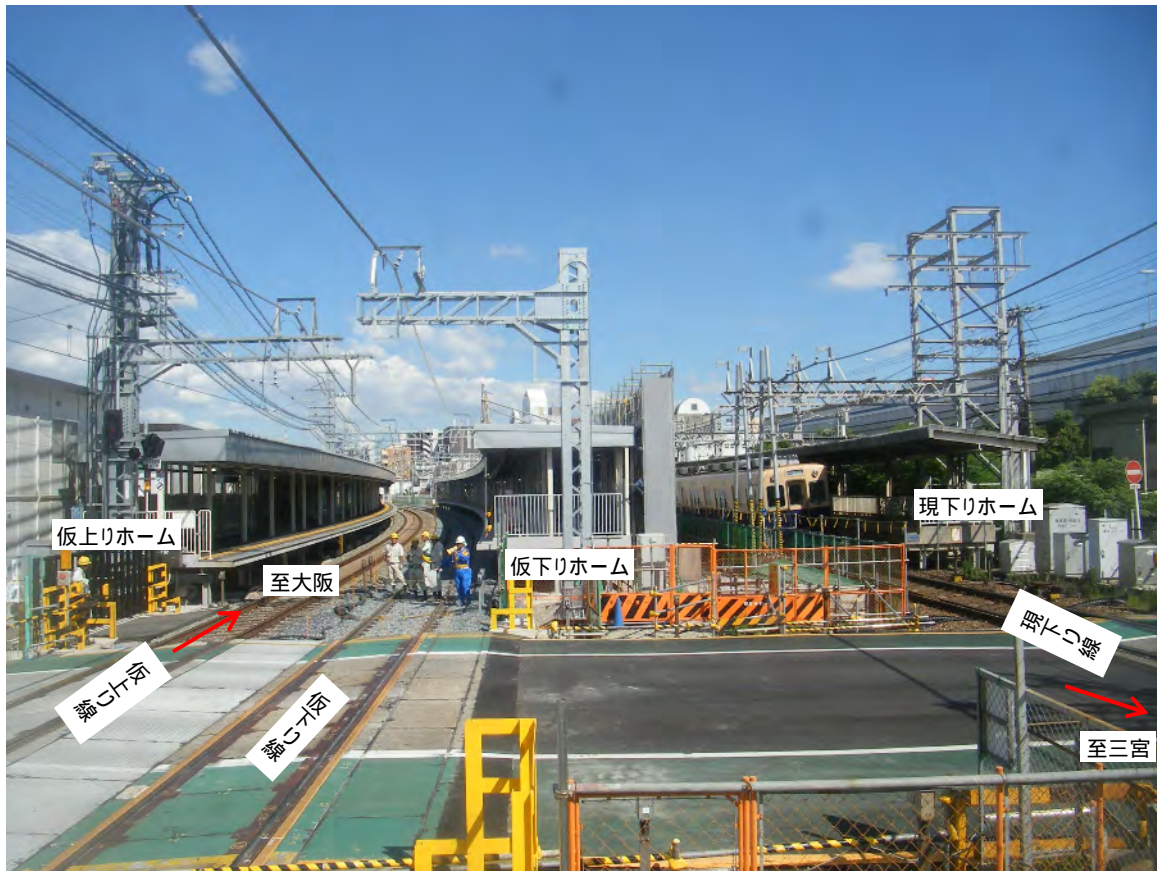
鳴尾駅状況(鳴尾駅西踏切から)
