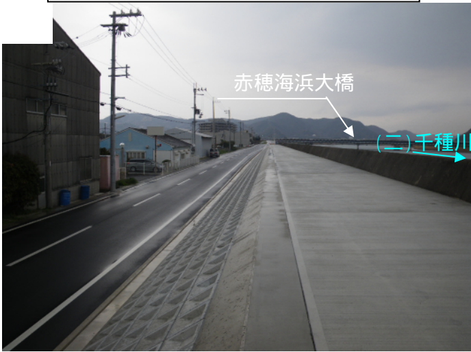
整備済区間(赤穂海浜大橋下流)
