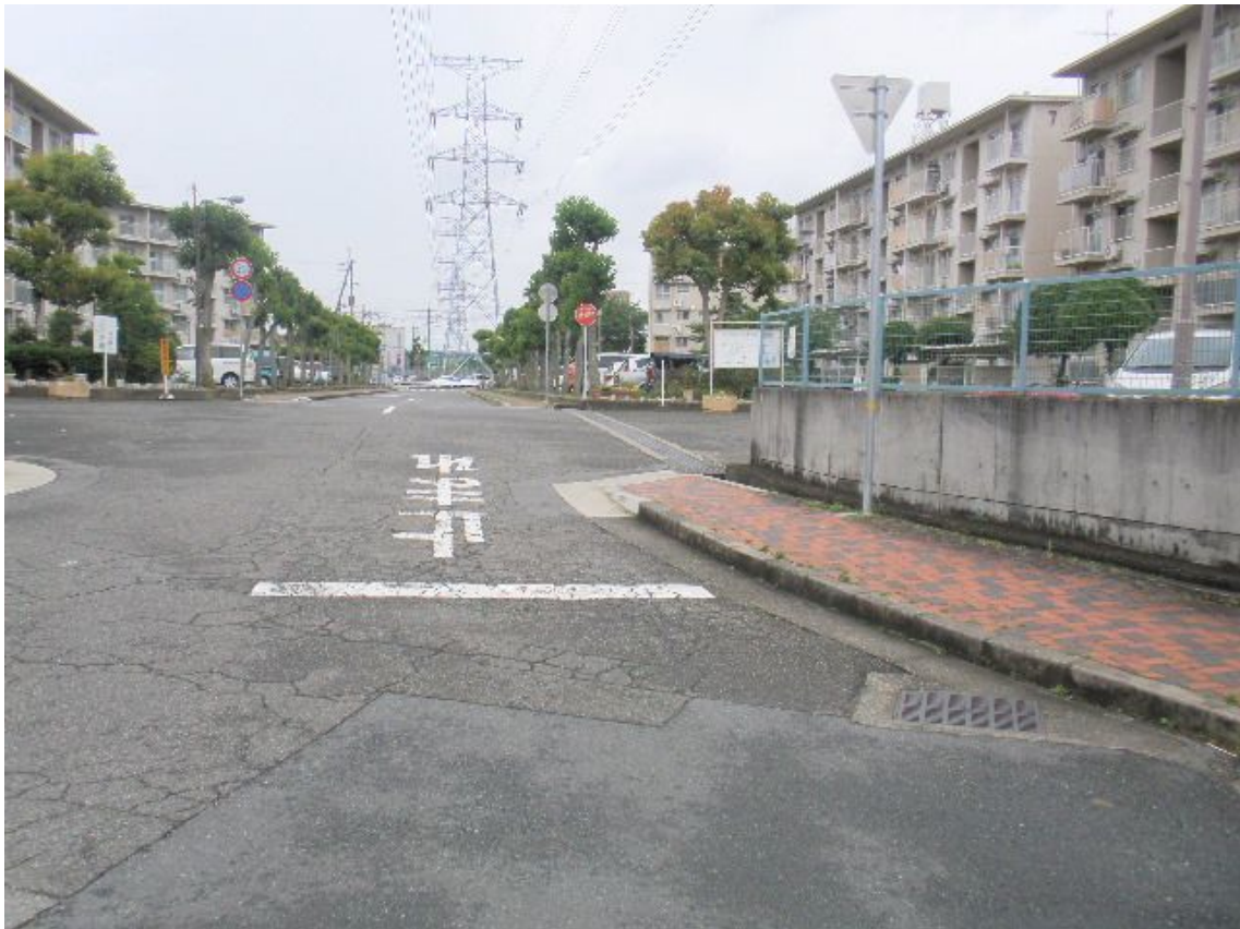
宝塚山本住宅現状写真 外観 2：高圧電線の状況
