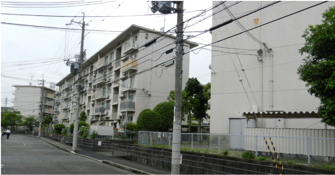
宝塚山本住宅現状写真 外観 1：住棟東側より
