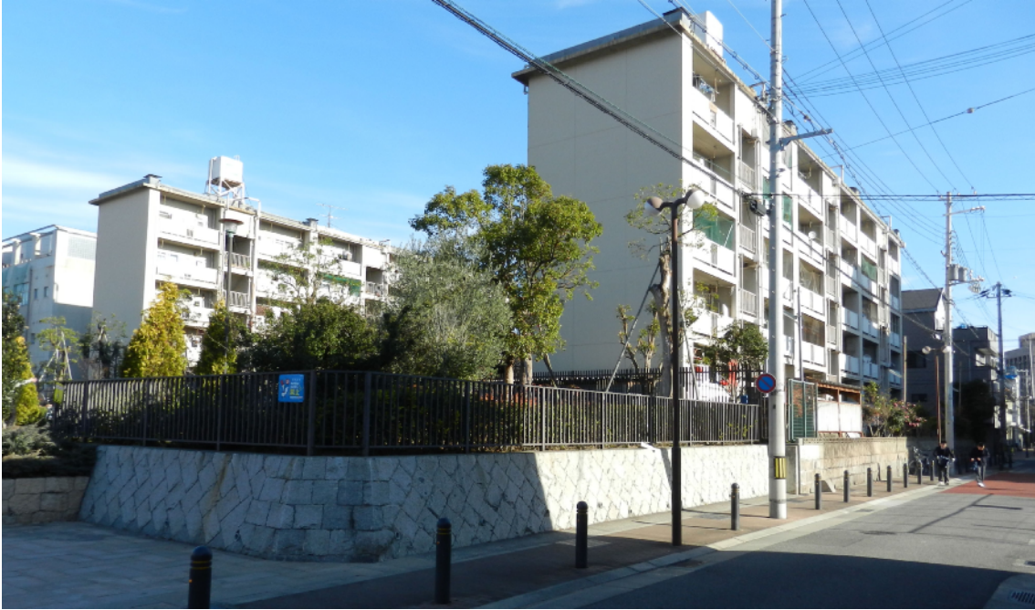
中村住宅現状写真 外観 1：住棟西側より
