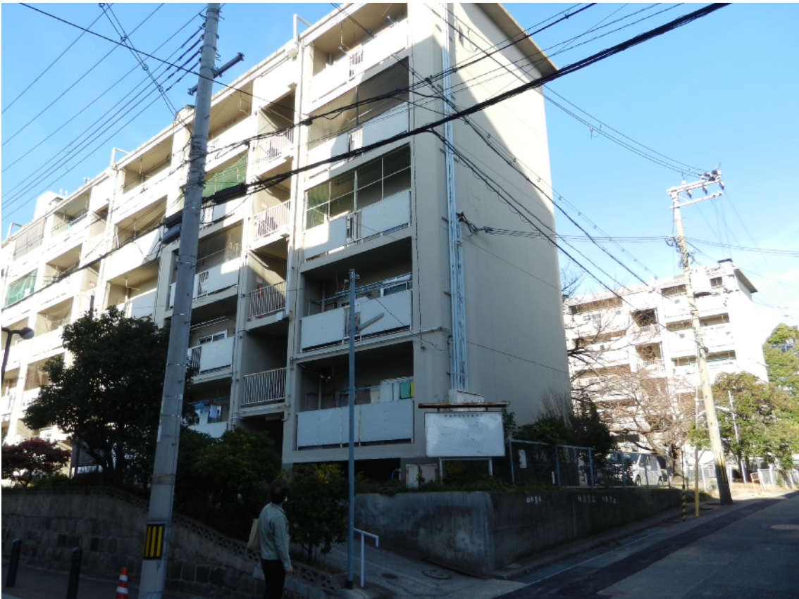
中村住宅現状写真 外観 2：住棟東側より
