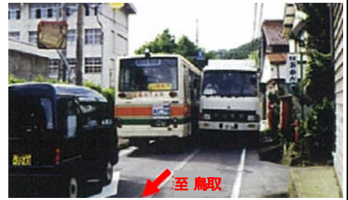
【写真】旧道(国道178号)香住区矢田(整備前)
