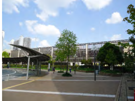
橋上化された駅ホーム
