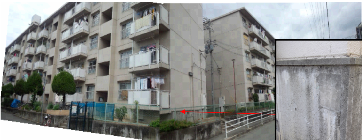
外観 3 : 住棟南側
