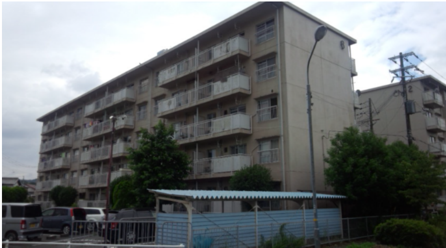
外観 1 : 住棟北側
