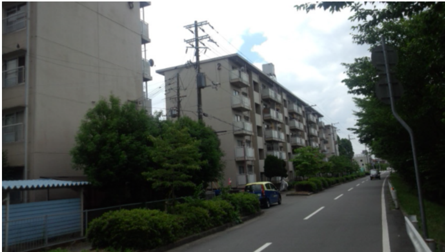
外観 2 : 住棟北西側
