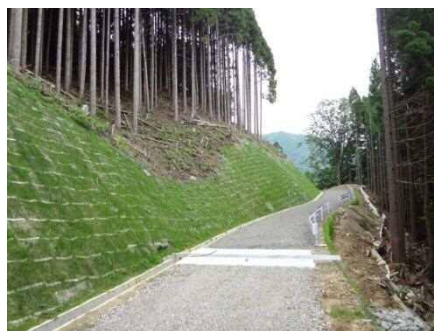
H24施行法面 (植生ネット工の植生状況)
