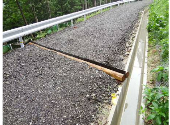
③ 上置砕石工と水切工を設置した路面の状況
