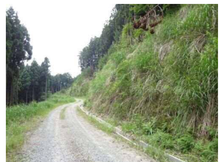
H14施行法面 (周辺の在来種の植生へ遷移)
