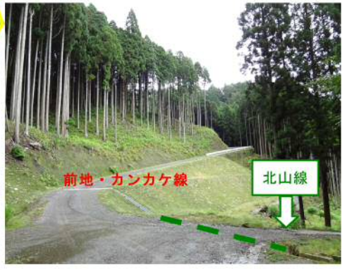
当路線と市管理林道「北山線」との接続状況
