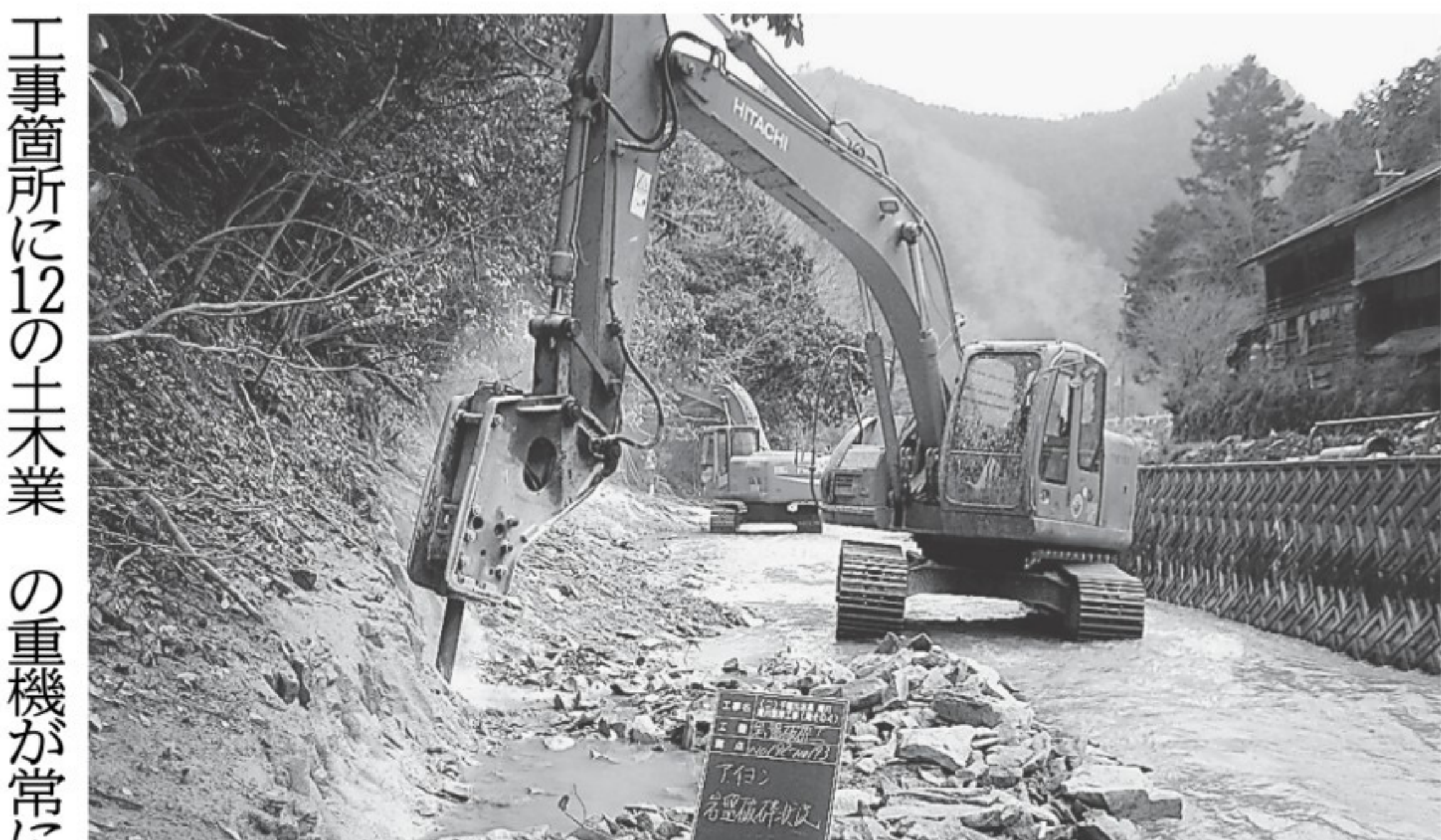
庵川の護岸工事を進める重機。地域住民と行政が協議を重ね、生活に支障がでないよう配慮もなされた＝佐用町庵地区
