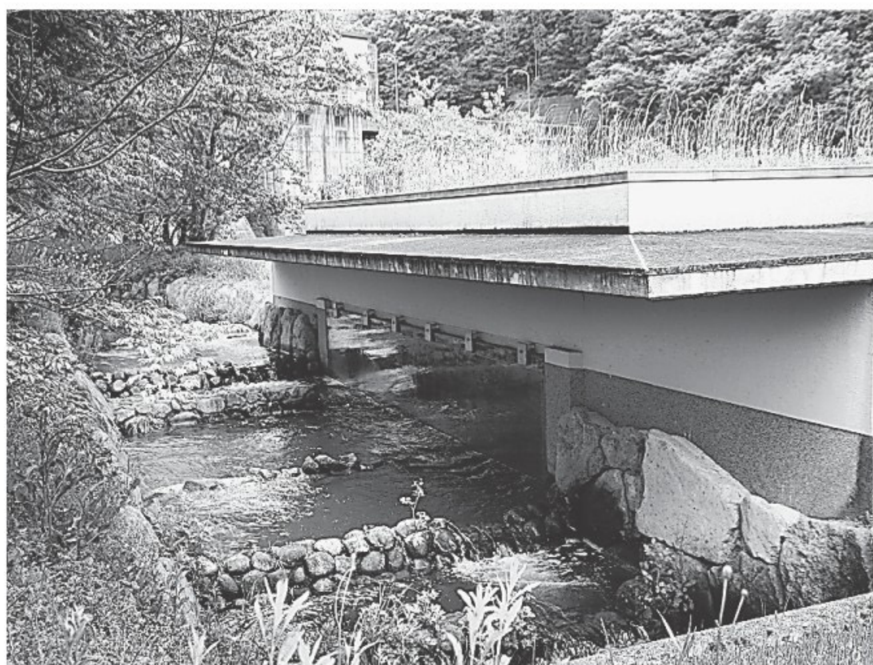
ダムで分断された生態系を回復するため、全国に先駆けて整備した多自然型魚道。魚道を通る生き物が観察できる「自然の水族館」
