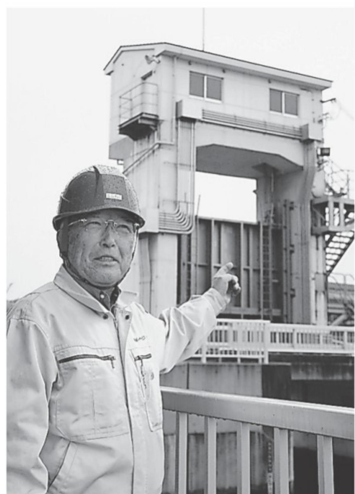
「旧施設の時水門上で操作しないと行かなかったが、新施設は操作室から遠隔操作できるようになった」と藤原さん
