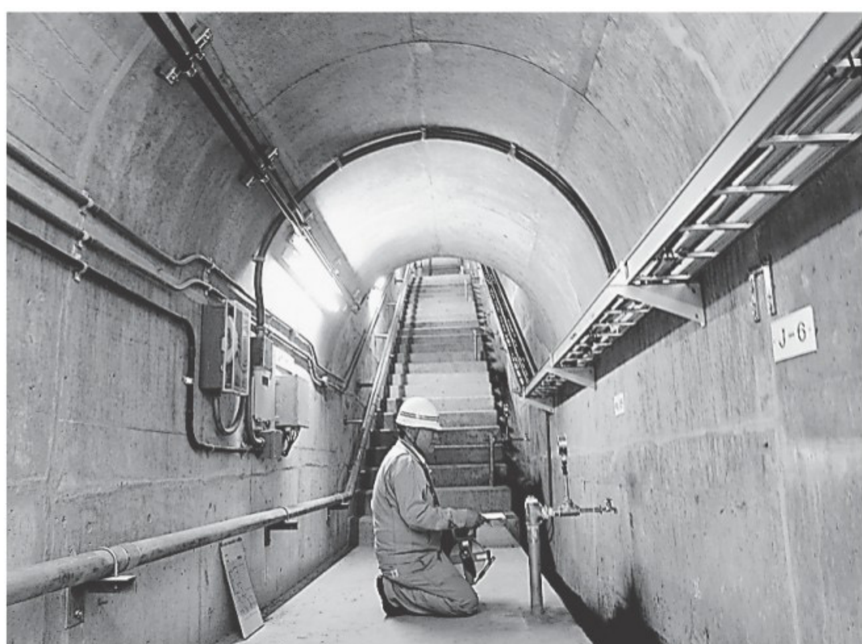
ダム堤体内には内視鏡検査のように検査できる監査廊があり、漏水量をチェックする
