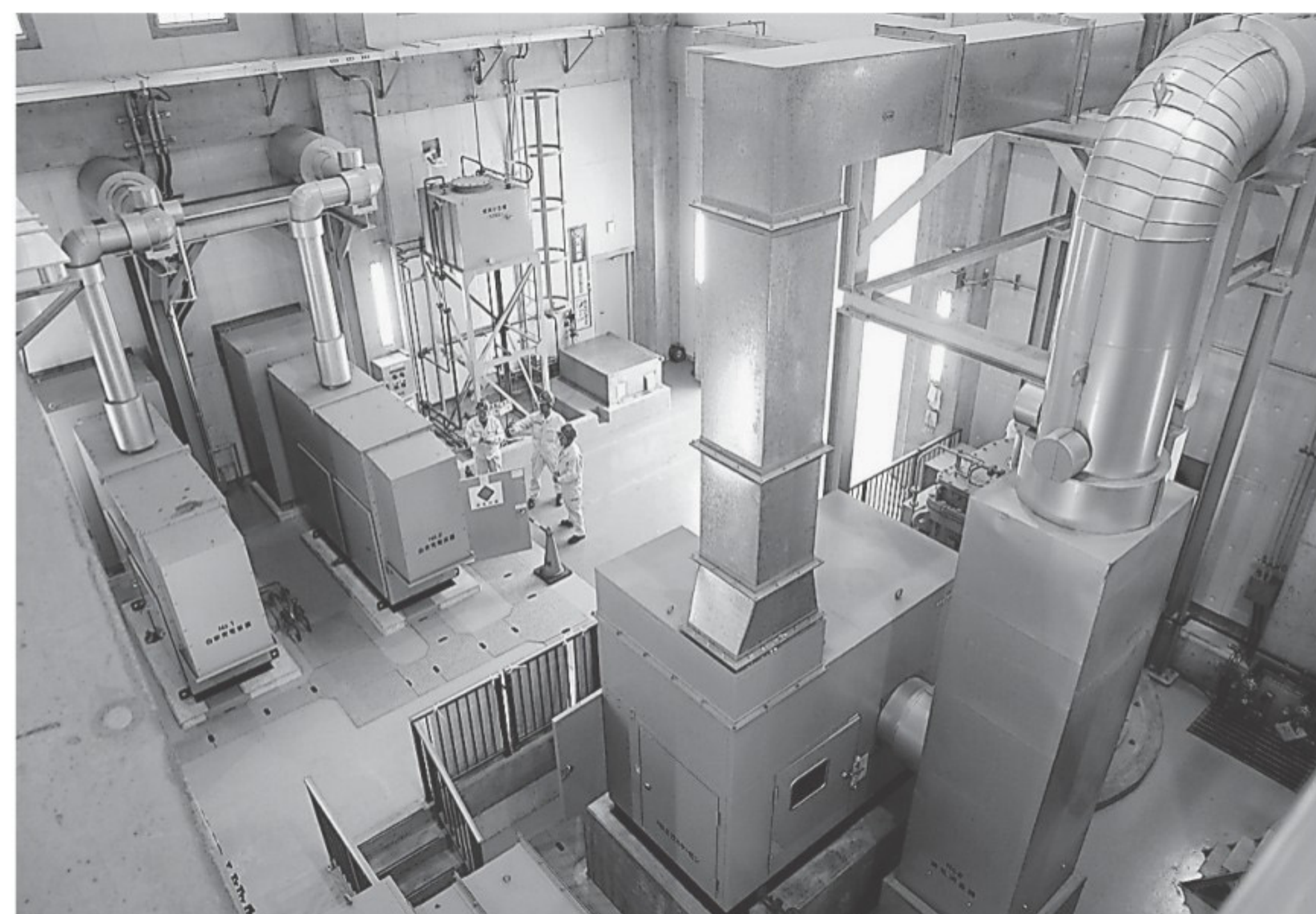
自家発電機や排水ポンプに異常がないかを点検。排水機場の停電時でも稼働できるように、自家発電機を設置している。いずれも姫路市飾磨区宮
