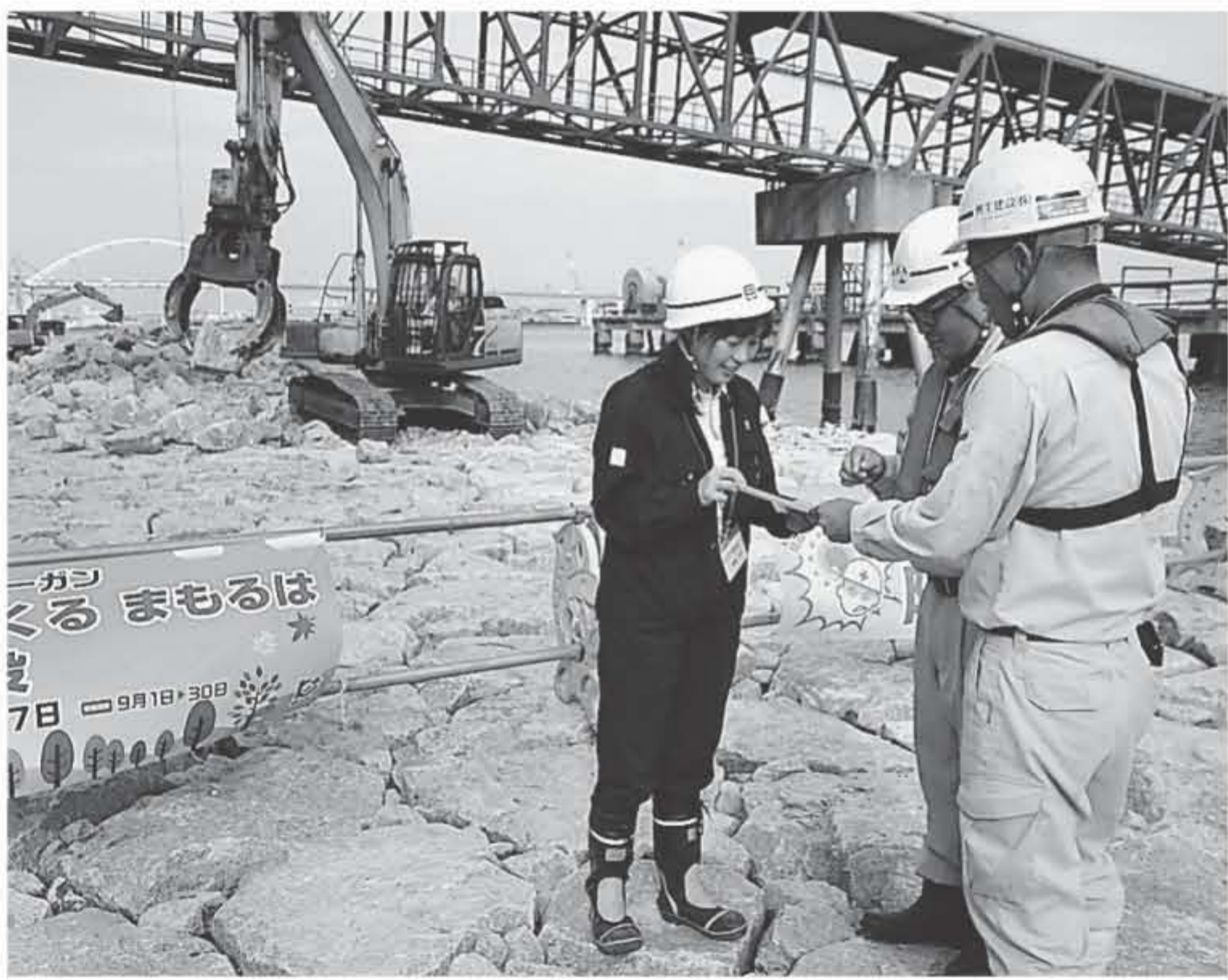
防潮堤の補強工事について工事関係者と打ち合わせする雨森さん＝尼崎市東海岸町
