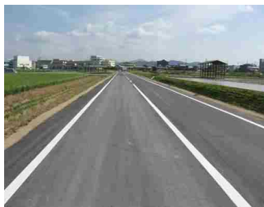
ほ場内に計画的に配置・整備された市道
