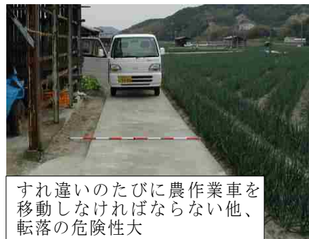
整備前：幅員 2.0m 程度
