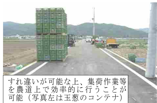
整備後：幅員 5.0m に拡幅
