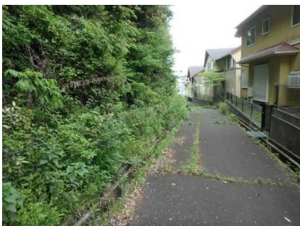
①保全対象とがけの状況
