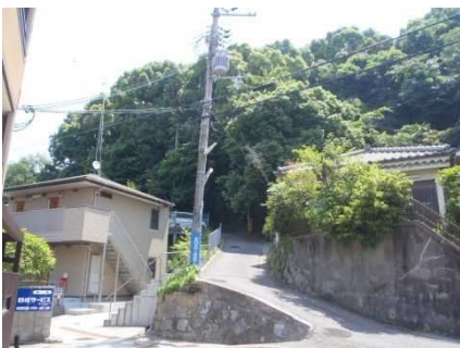
①保全対象とがけの状況
