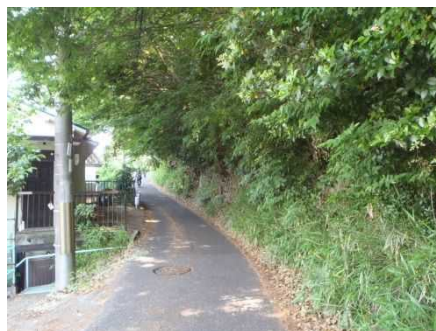
②保全対象とがけの状況
