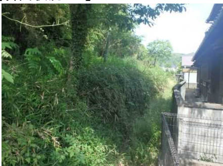
②斜面状況(人家裏)
