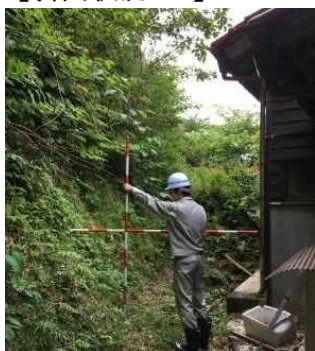
②斜面状況(人家裏)
