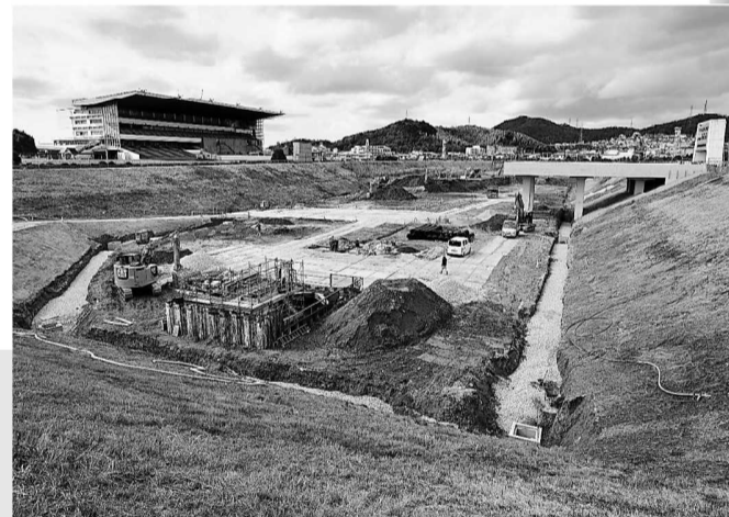
ICTを活用して施工が行われている船場川洪水調節池整備工場の現場＝姫路市広峰2、姫路競馬場
