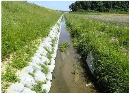
小動物の脱出や水生植物の保護のため、緩勾配の法面、底面の一部を土水路とした排水路
