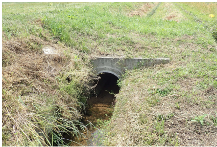
安全に通行できる横断暗渠
