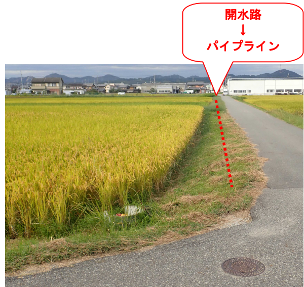
パイプライン化により水路へ転落の恐れがなくなった農道
