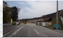
建設が進む農道の池内工区
