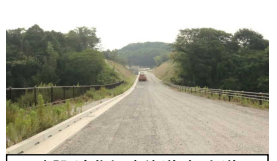
建設が進む連絡道路(市道)
