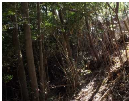
③斜面状況
