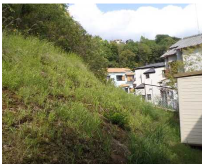
②人家裏の状況
