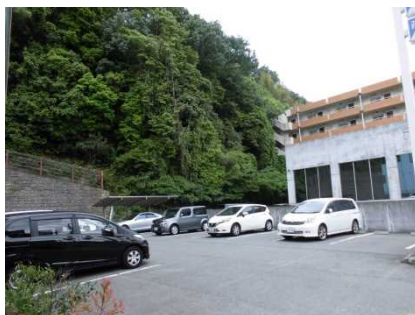
③保全対象とがけの状況
