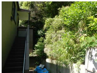
③保全対象とがけの状況
