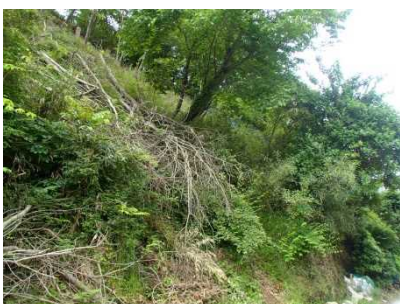
②斜面状況(人家裏)
