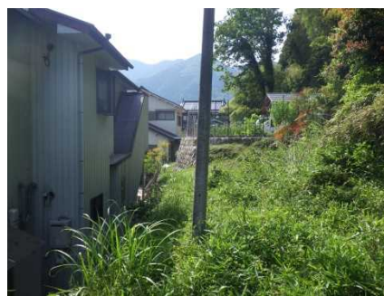
③保全対象とがけの状況
