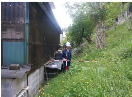
②斜面状況(人家裏)
