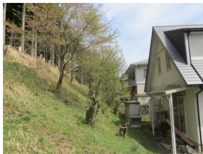
③保全対象とがけの状況
