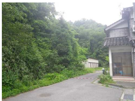
③保全対象とがけの状況
