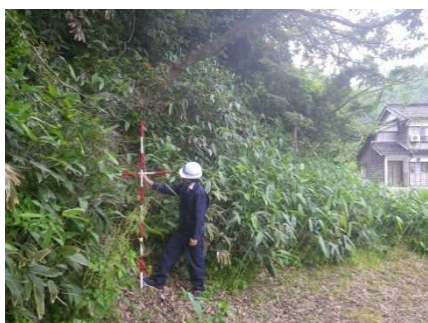
②斜面状況(人家裏)
